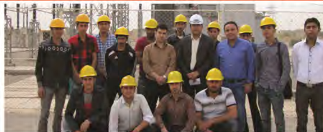
مخابرات و PLC، سیستم AC/DC، باتری خانه، محوطه سوئیچ یارد و اتاق لوازم آموزشی موجود در پست بازدید کردند.
