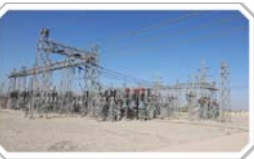
فیدرهای های پست مهریز اصلاح و بهینه‌سازی شدند
