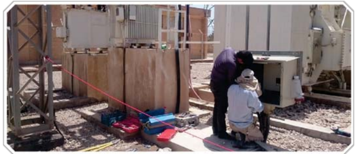
پروژه‌ی اصلاح و بهینه‌سازی تابلوهای AC پست‌های ASEA شرکت برق منطقه‌ای یزد تکمیل شد و تمامی این تابلوها برق‌دار شدند.
