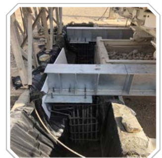
مدیر امور انتقال نیرو شرکت برق منطقه‌ای یزد از انجام طرح مقاوم‌سازی ترانسفورماتورها در برابر زلزله خبر داد.
