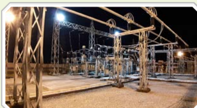
برق‌دار شدن دو فیدر و خط ۶۳ کیلوولت کارخانه گندله‌سازی در پست سرواردگان
