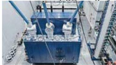
ترانسفورماتور قدرت با عایق استری و مبدل حرارتی مورد استفاده
